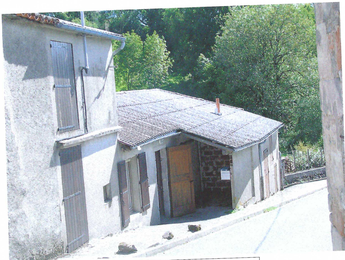
DP4 – FAÇADE OUEST ÉTAT ACTUEL – Vue du nord-ouest
