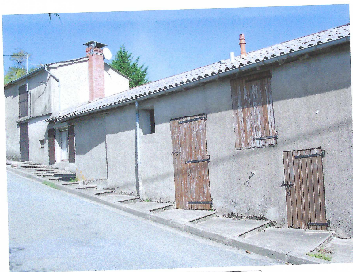
DP4 – FAÇADE OUEST ÉTAT ACTUEL – Vue du sud-ouest
