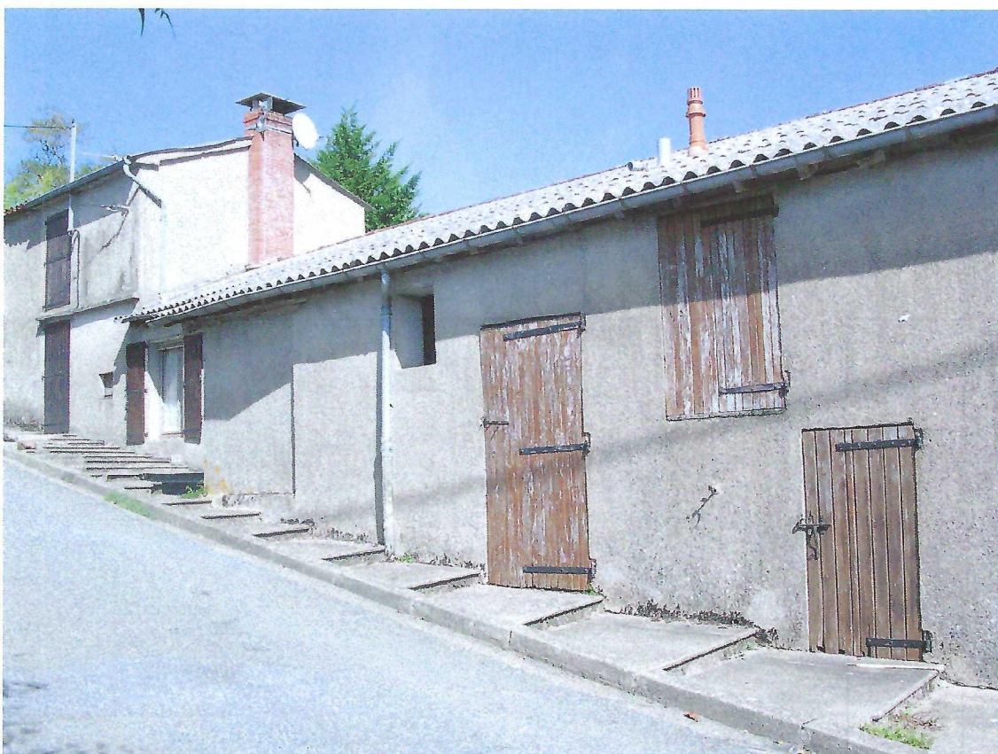
DP4 – FAÇADE OUEST ÉTAT ACTUEL – Vue du sud-ouest
